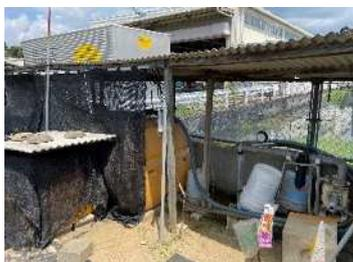
井戸水の流量では園内の同時かん水量が賅えないため、貯水タンク2基を設置して水量を確保
